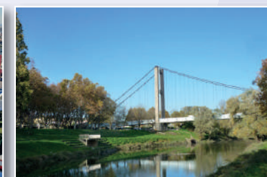
Pont de Vernaison
