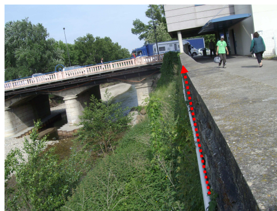
Passage en encorbellement de la canalisation de refoulement
