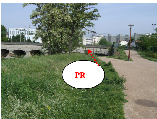
Emplacement prévisionnel du poste de relèvement
