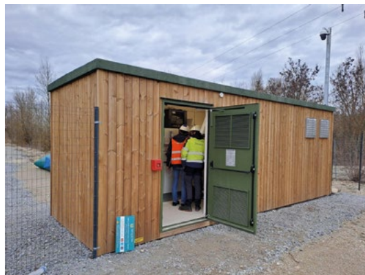
Poste de livraison de la centrale, point de connexion au réseau Enedis
